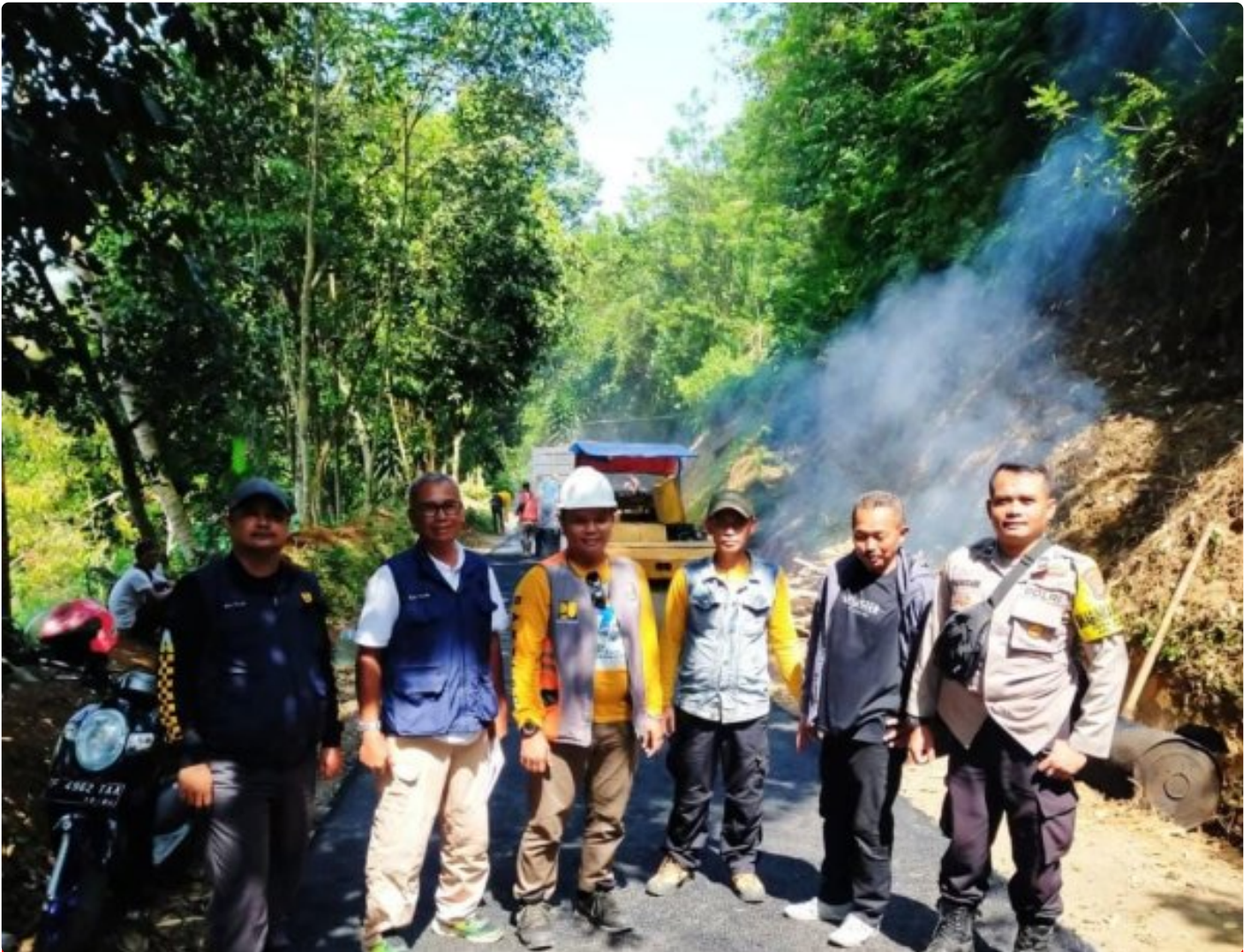
Bhabinkamtibmas Desa Munjul Polsek Nagrak Monitor Pembangunan Jalan Desa
