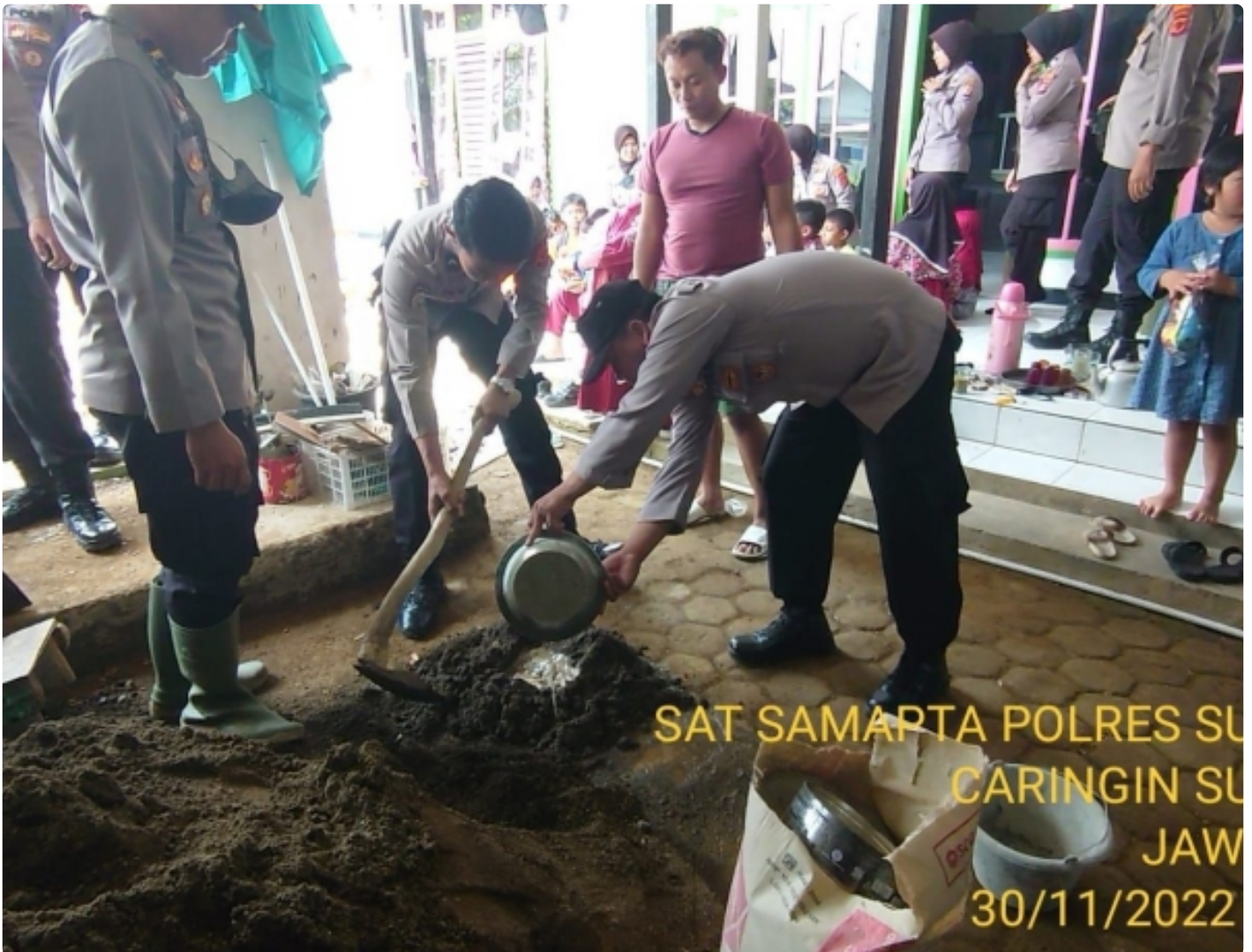
Kapolres Sukabumi Bantu Perbaiki Rumah Warga Yang Rusak Akibat Gempa
