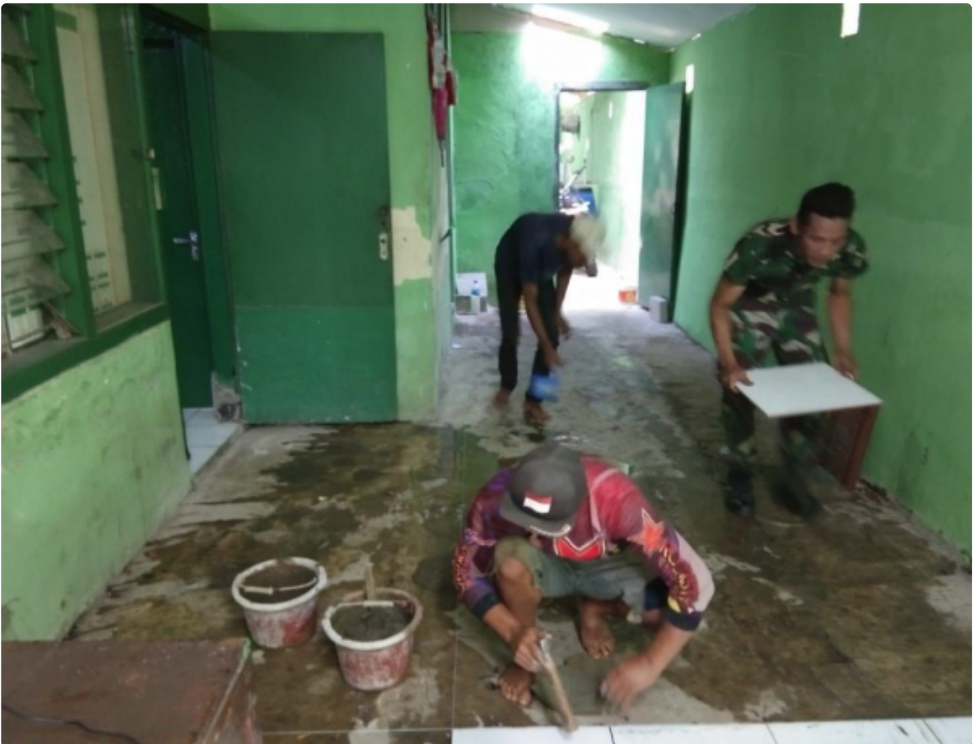
Koramil 0622-04/Cikidang Lakukan Perbaikan dan Pemeliharaan Kantornya
