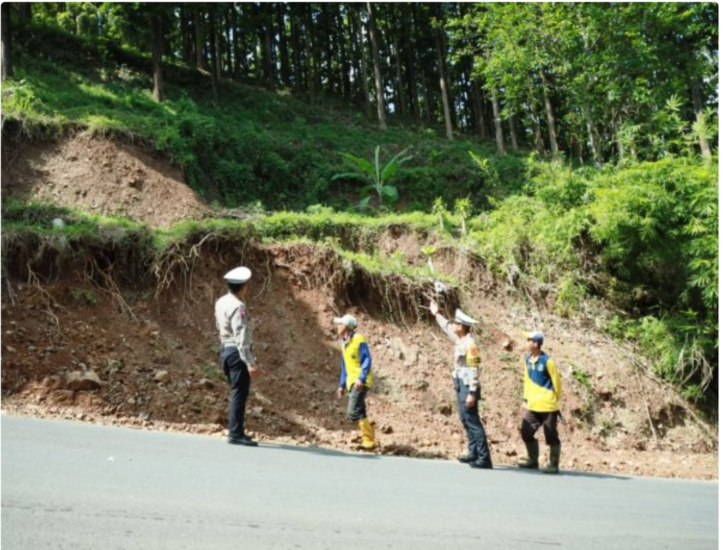
Survei Tanah Longsor di Cikidang Sukabumi, Akp Fiekry Himbau agar Pengendara selalu Waspada
